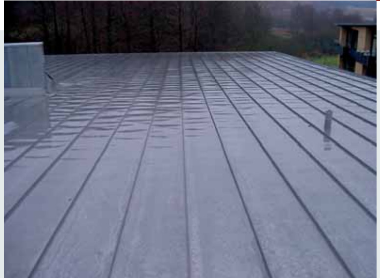
30 meter lange zinkbaner, hvor vand vil kunne stuve op over false ved heftig regn og blæst.
