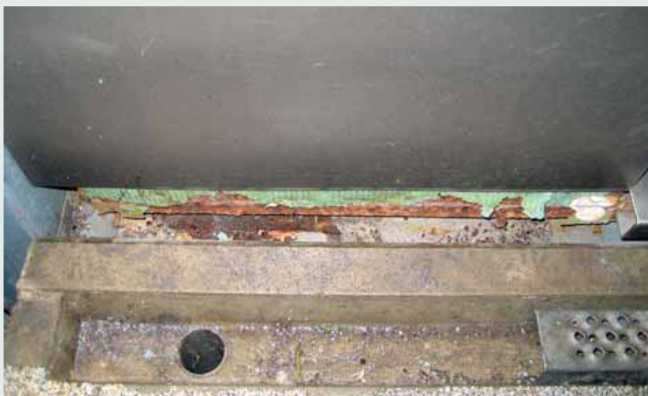
Rust bag de rustfrie stålplader på elevatorfront
