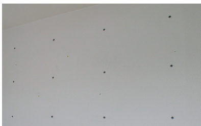
Borehuller i væggen.
